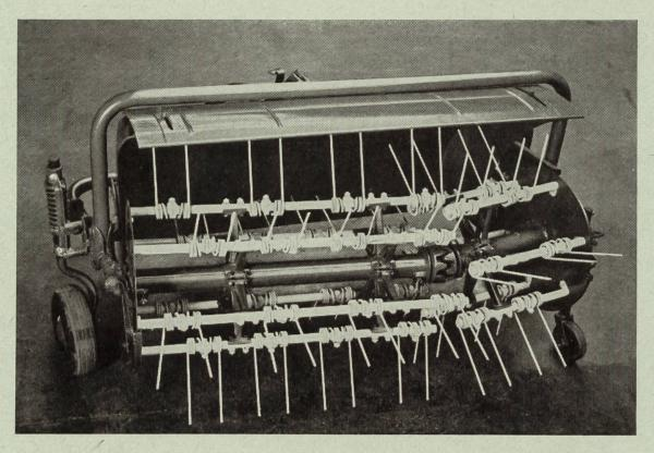
Fig. 2b: Epandeuse d'herbe à tambour avec arbre en deux parties.
