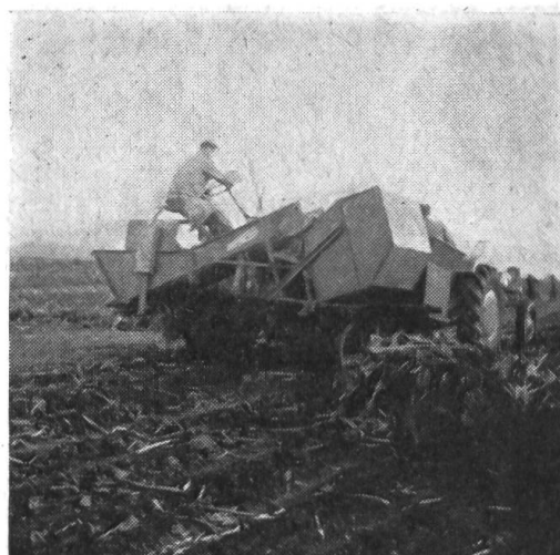
Fig. 7a et 7b: Arracheuses-aligieuses Schmotzer et Stoll à récipient collecteur. Les betteraves et les feuilles sont déposées simultanément et séparément en andains transversaux.
