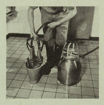
Un rinçage immédiat, par aspiration d'eau à travers les manchons trayeurs et la tuyauterie, équivaut à un demi-nettoyage.
