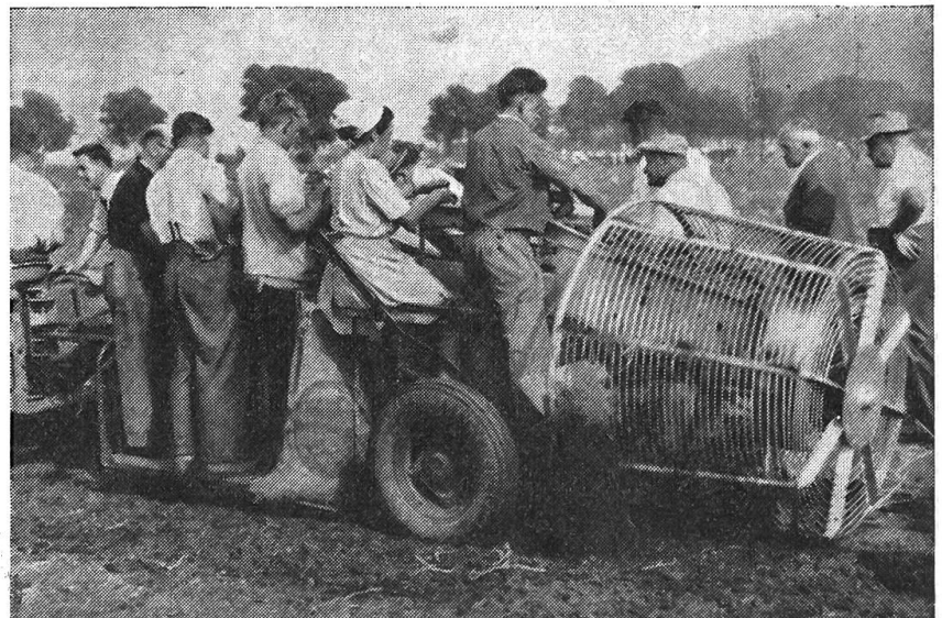
Fig. 6: La machine à récolte totale Samro, de Kunz
