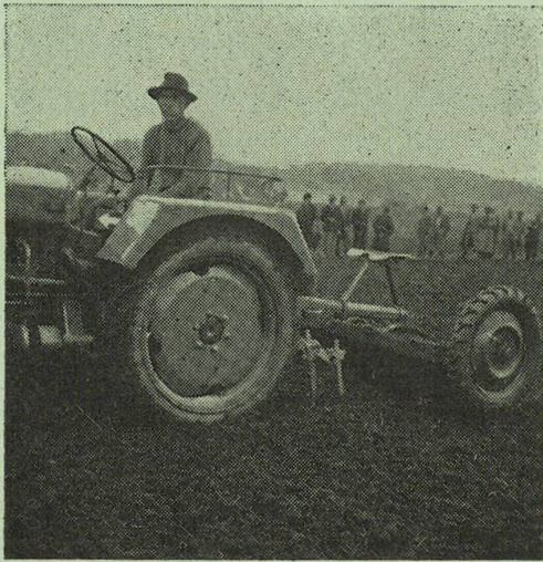
Fig. 26: Passage du rouleau brise-mottes avant les travaux d'ensemencement en se servant d'un effaceur de traces (des dispositifs d'adhérence sont utilisés après les semailles).
