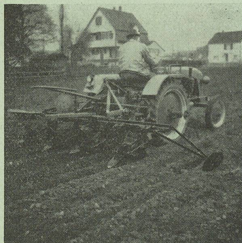
Fig. 2: Creusage de trous de plantation à l'aide d'un instrument universel porté
