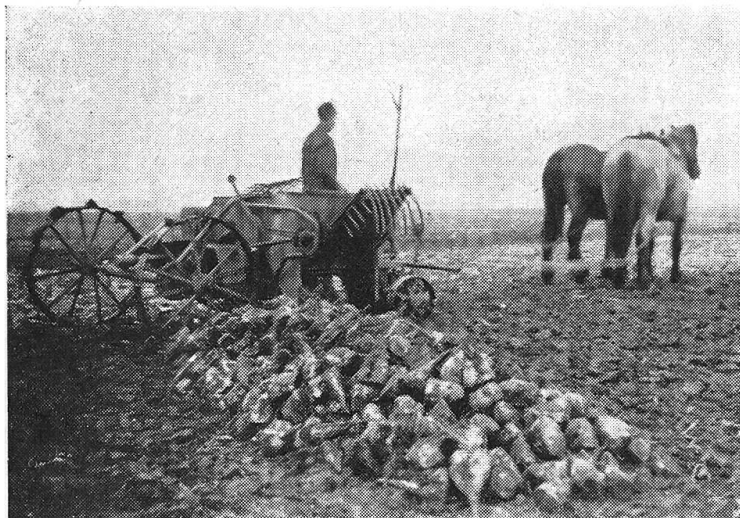
Fig. 11: La machine à récolter les betteraves Hamster, à 1 rang, pour traction animale ou motorisée.
