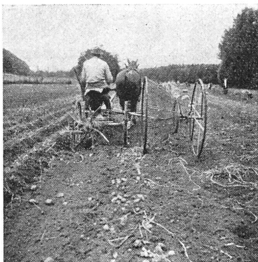
A gauche: Grille d'arrêt tronconique B ä r t s c h i accrochée parallèlement à une arracheuse à fourches rotatives tirée par un cheval. Elle allège considérablement le travail de ramassage des tubercules (cette photo n'a pas été prise à Witzwil).
