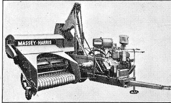
**PRESSE RAMASSEUSE «PICK-UP»** à haute densité **MASSEY-HARRIS** pour accouplement au tracteur avec moteur auxiliaire 31-39 ch ou par prise de force. Largeur de travail (pick-up) 1,50 m. Noueux doubles sisal. Dimensions des bottes 35 / 45 / 90 cm. Capacité de travail à la minute 3 bottes au minimum, selon conditions de récolte.
