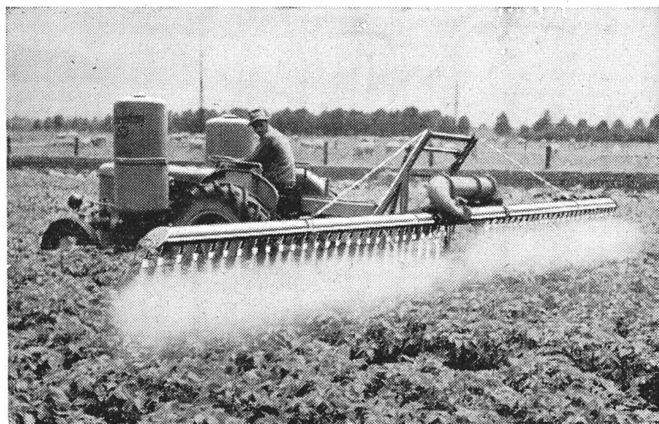
Fig. 12: Appareil brouillard avec barre de traitement à 50 buses (largeur de travail de 8 m).
