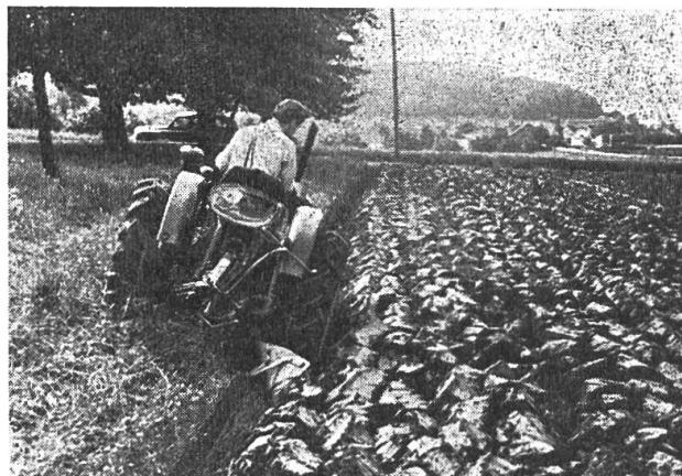
... exécute des **labours et remorquages** étonnantes, grâce à son **système-balance** et à ses nombreuses vitesses. — **Relevage automatique des outils** (charrue, appareil universel, fraise, etc.) par le système-balance du tracteur.
