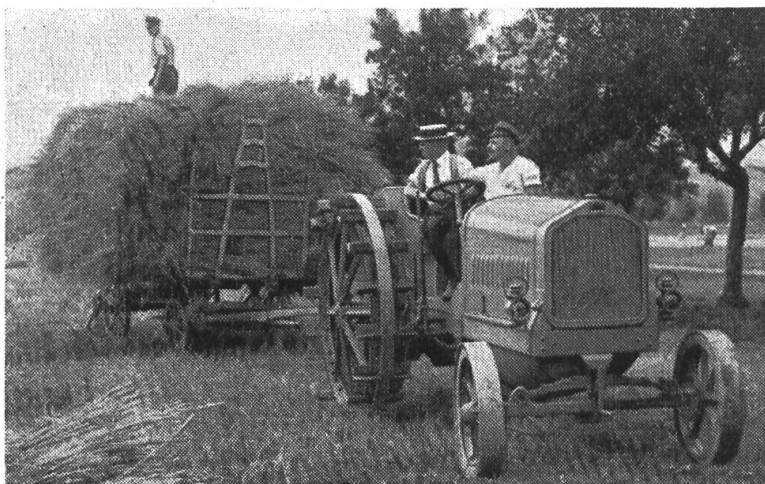
35 Pour empêcher que les crampons n'arrachent le gazon et ne détériorent les chemins, on utilisait autant que possible des protections (bandage superposable).
