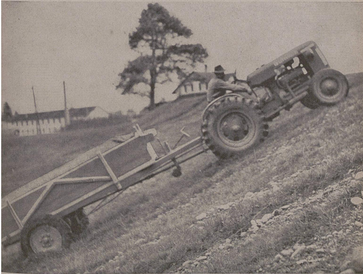
La remorque «Stura» (Uesslingen TG) avec essieu moteur «Kessler» est la grande nouveauté qui contribue à la motorisation de l'agriculture. Un tracteur léger avec une remorque entraînée par la prise de mouvement est d'un prix plus avantageux et d'un rendement supérieur.
