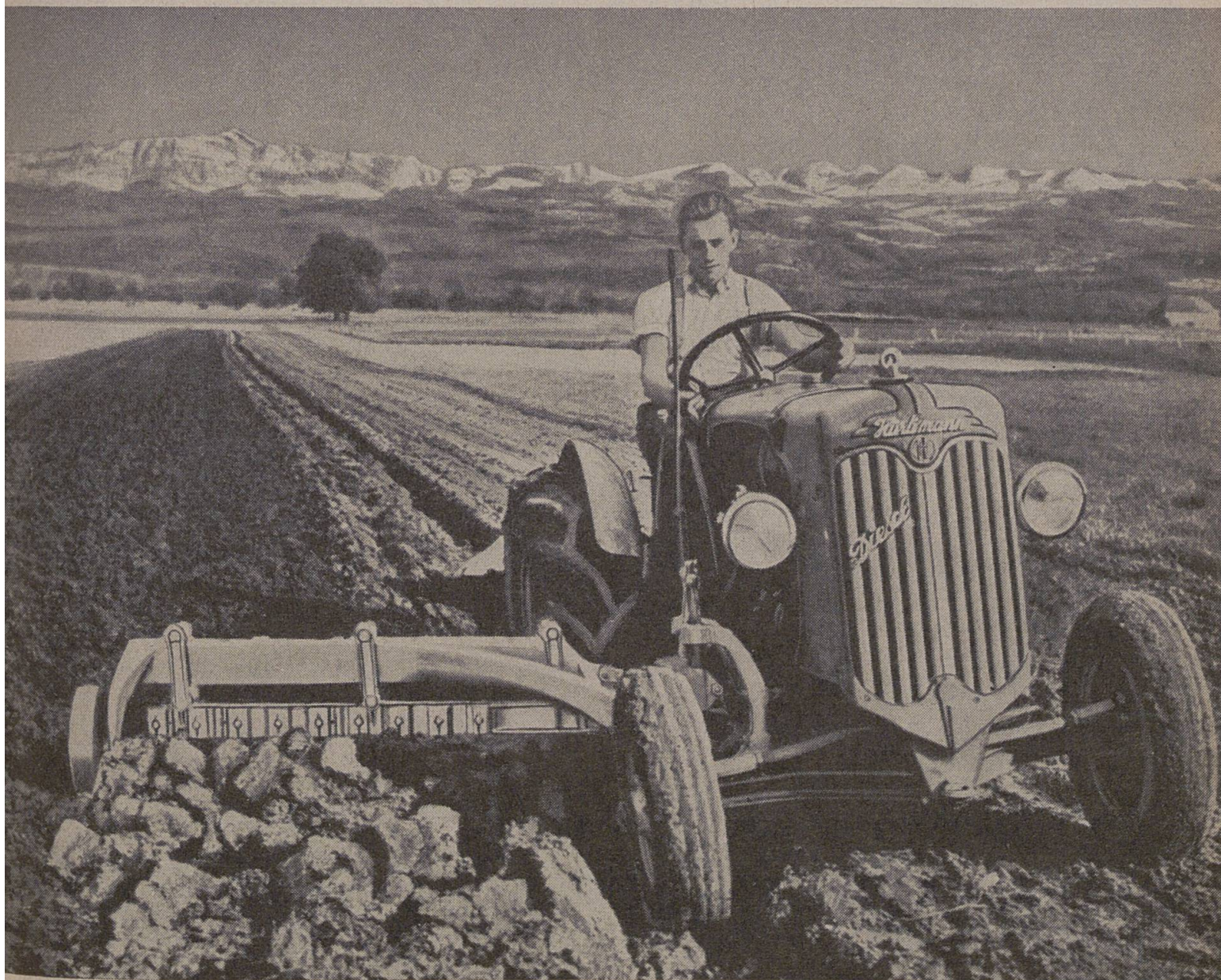
Tracteur Diesel Hurlimann avec herse à moteur au labourage et hersage simultané en terrain très lourd
