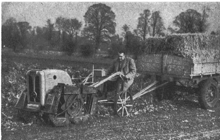
fig. 4: Tracteur à un axe avec chenilles, tirant une remorque.
