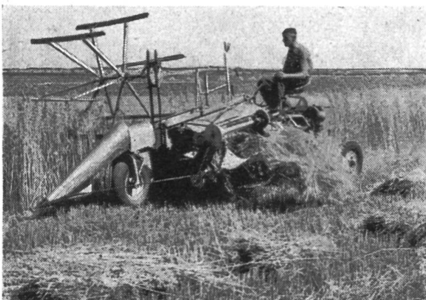
Fig. 1: Moissonneuse-lieuse à barre de coupe frontale, modèle 1952, sur tracteur de 15 CV.
