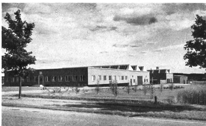
Les nouveaux bâtiments des établissements d'Ultuna.
