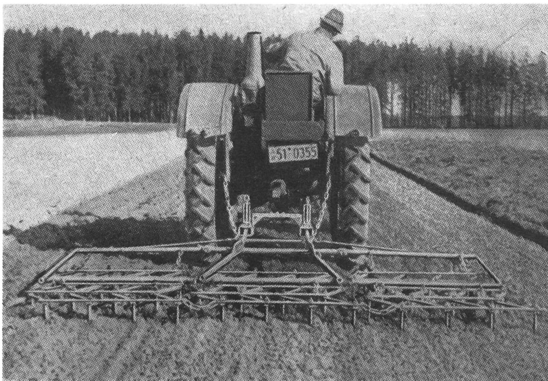
Fig. 6: Tracteur à toutes fins de Lanz, accouplé à une herse à 3 éléments. La herse peut être relevée hydrauliquement. Le dispositif d'accouplement (Eberhardt) est digne d'attention, car il convient aussi bien à la charrue, au cultivateur, etc., et s'adapte à n'importe quel modèle de tracteur.
