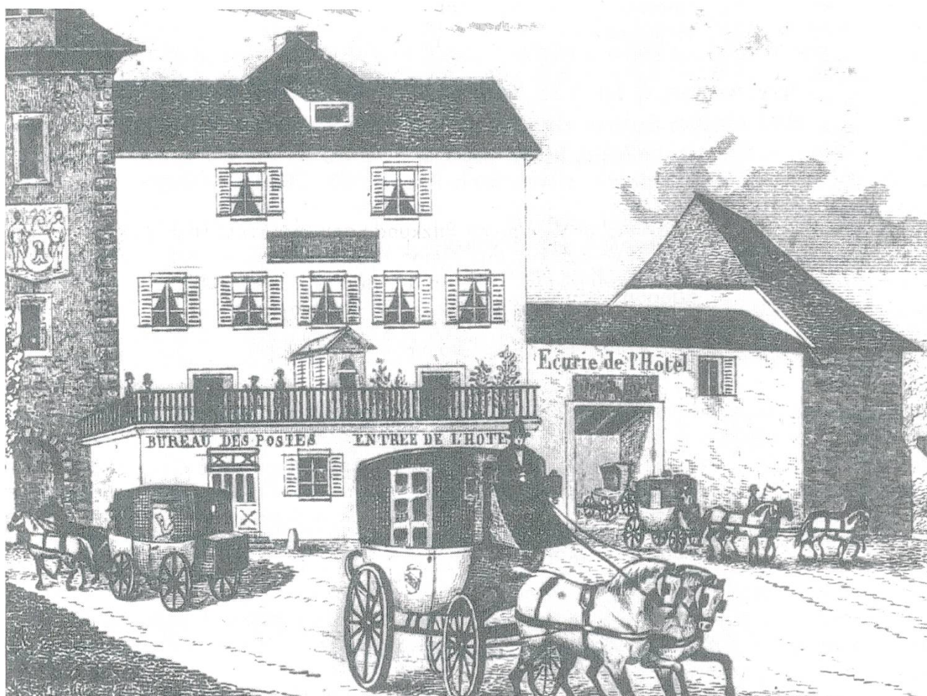
Delémont, entre 1719 et 1762 / Delémont, zwischen 1719 und 1762
