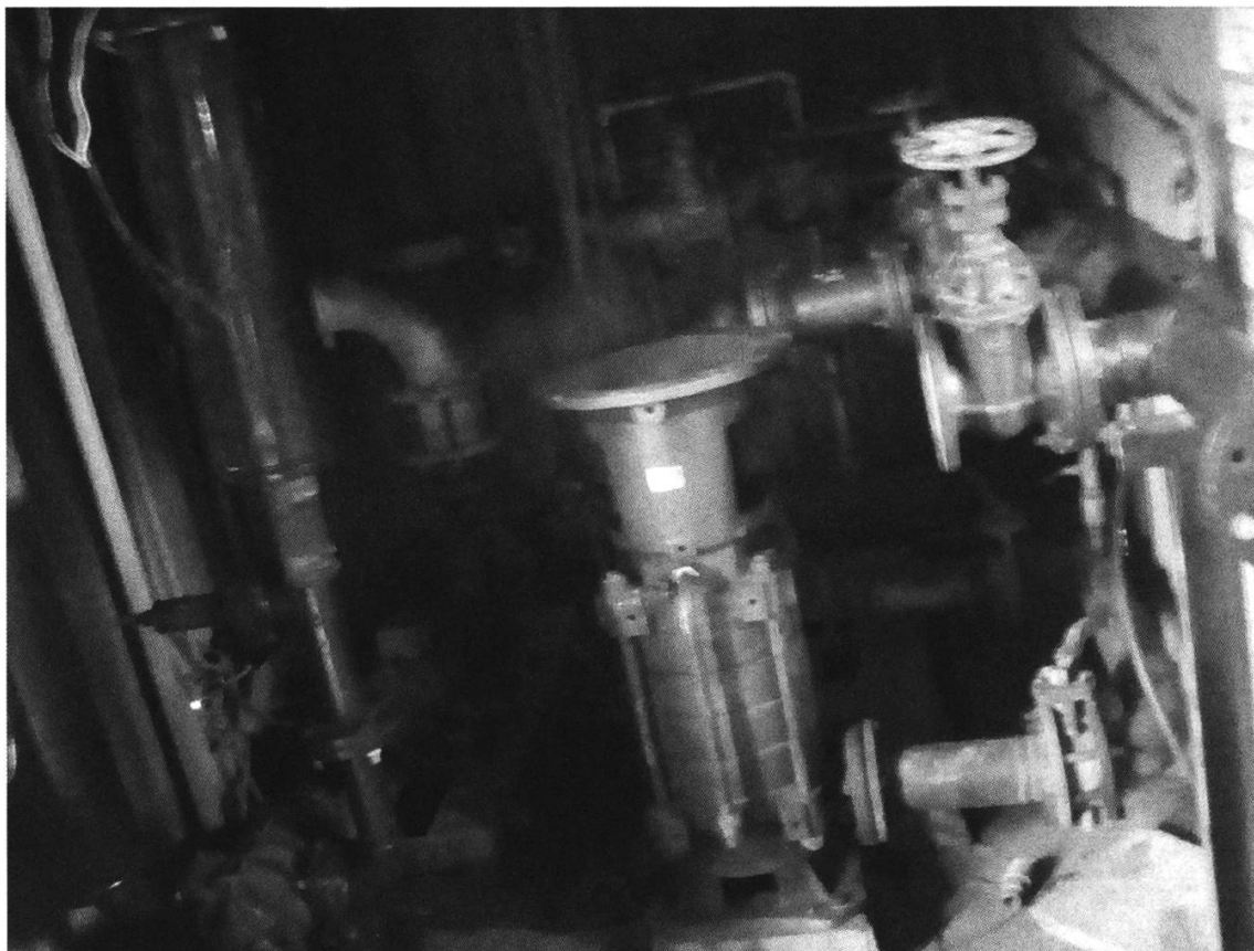
Figure 2: Vue interne de la station de traitement des eaux de Ndikiniéki, photographie de l'auteur, 11 décembre 2019. Au milieu des machines on aperçoit le moteur de pompage des eaux qui est endommagé et nécessite d'être remplacé afin d'assurer le ravitaillement en eau potable des populations de Ndikiniéki et de Makénéné. Cette pièce est indispensable dans le fonctionnement du système d'adduction d'eau.
