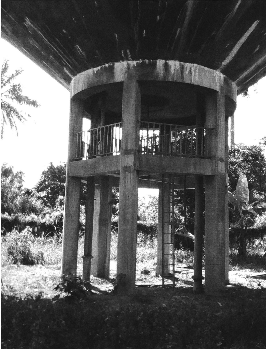
Figure 6: Château d'eau de Makéné, vue de la partie inférieure, photographie de l'auteur, 11 décembre 2019.
