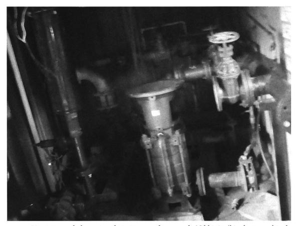
Figure 2: Vue interne de la station de traitement des eaux de Ndikiniméki, photographie de l'auteur, 11 décembre 2019. Au milieu des machines on aperçoit le moteur de pompage des eaux qui est endommagé et nécessite d'être remplacé afin d'assurer le ravitaillement en eau potable des populations de Ndikiniméki et de Makénéné. Cette pièce est indispensable dans le fonctionnement du système d'adduction d'eau.
