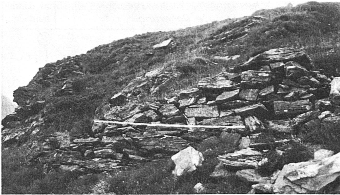
Abb. 6. Alte Gemmi – Südseite (Tafel 3, Alte Gemmi, Ziffer 12). Letztes Reststück des gebauten oder gebahnten Weges über die Alte Gemmi. Vergleichsstrecke: 2 m. Bildmitte Az 5300 A‰. (Aus AERNI 1971, Abb. 33.)
