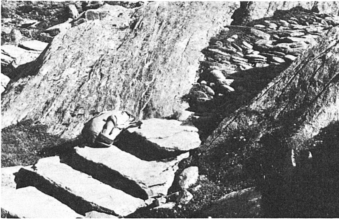
Abb. 2. Monte Moro – Nordseite: Alp Distel. Ein kerbförmiger Einschnitt zwischen grossen Blöcken wurde durch den Einbau flacher Platten (Treppenpflaster) und kleiner, steilgestellter Platten (Steilpflaster) begehbar gemacht. Dieses kleine Wegstück ist als «gebauter Weg» zu bezeichnen, der übrige Teil des Passweges gehört in der Mattenstufe zum «gewordenen» und «gebahnten» Wegtypus. – Standort: LK 1349 – 640 800/96 600 / 2225 m; Bildmitte Az ca. 2400 A‰. (Aus AERNI 1971, Abb. 3.)
