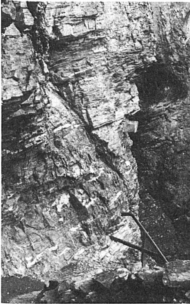
Abb. 23. Gemmi-Südseite. Jahrzahl beim «Chlöfe» (Tafel 3, Ziffer 22). Eingesprengrter Weg aus der Zeit von 1739–1741. Wegoberfläche verläuft auf dem Anstehenden, teilweise mit Feinschutt bedeckt. Talseits wurde der Fels mauerartig stehengelassen und dient mit einer aufgesetzten Trockenmauer als Wegabschrankung. Oben im Bild ist links der Mitte ein ca. 25 cm hohes, schräg nach links fallendes Felsband zu erkennen, das Spuren einer eingemeisselten Jahrzahl trägt (siehe Abb. 24). An der Felskante rechts oberhalb der Bildmitte ist der «Chlöfe», ein eingesetztes Balkenstück, sichtbar. – Standort: LK 1267 – 613 175/138 070 / ca. 1970 m; Bildmitte Az ca. 300 A‰. (Aus AERNI 1971, Abb. 30.)
