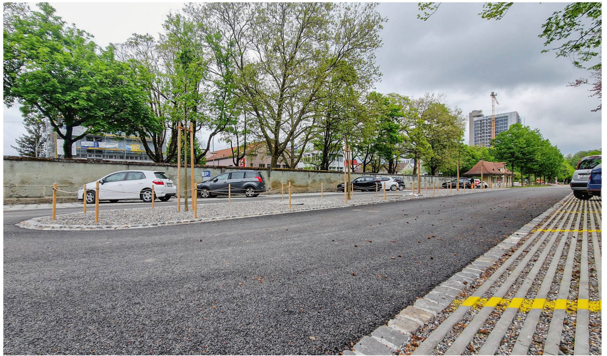
Abb 1 Schwammstadt-pilotprojekt mit Sickerasphalt und erweitertem Wurzelraum unter der Zufahrtsstrasse am Schosshaldenfriedhof in Bern. Foto: ZHAW/Fachgruppe Pflanzenverwendung
