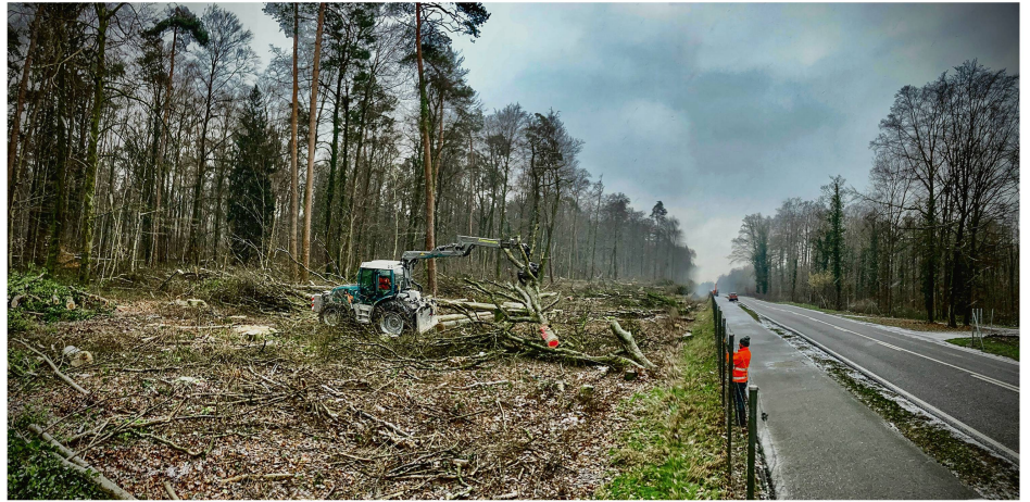
Um den Grundsatz «Realersatz» durchzusetzen, sind Vorabklärungen früh einzuleiten, und der Realersatz muss auf jeder Planungsstufe geklärt sein. Im Bild Rodungen in Bülach (ZH) 2023. Foto: Thomas Kuhn
