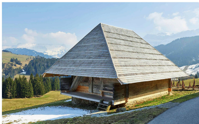
Glanzstück des restaurierten Käsespeichers ist das neue Schindeldach.
