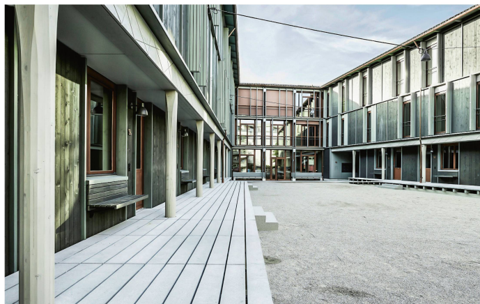
Holz ist das prägende Baumaterial der Siedlung Maiengasse in Basel. Foto: Kuster Frey
