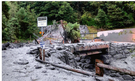
Fig. 2 Pour la deuxième année consécutive, une grande lave torrentielle s'est déclenchée dans le lit de la Losentse à Chamoson, le 11 août 2019.
