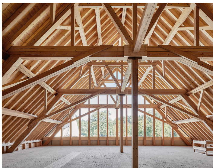
Fig. 1 Rénovation des écuries du Chalet-à-Gobet. Dans un style de réalité historique, c'est une magnifique charpente en épicéa et sapin qui a été installée fin 2017. Mille mètres cubes de bois brut provenant des forêts lausannoises ont ici été transformés localement en éléments de construction. Photos: Rémy Gindroz, Pont 12 Architectes SA
