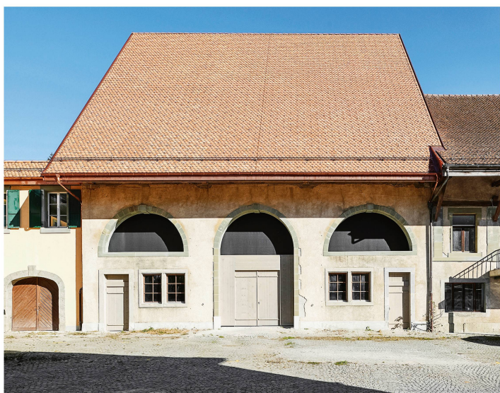
Fig. 1 Rénovation des écuries du Chalet-à-Gobet. Dans un style de réalité historique, c'est une magnifique charpente en épicéa et sapin qui a été installée fin 2017. Mille mètres cubes de bois brut provenant des forêts lausannoises ont ici été transformés localement en éléments de construction. Photos: Rémy Gindroz, Pont 12 Architectes SA
