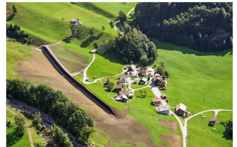
Abb 2 Der Schutzdamm oberhalb vom Dörfli Riemenstalden. Foto: AWN SZ
