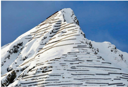
Fig. 2 Ouvrages de retenue au Schiahorn au nord-ouest de Davos. Photo: Stefan Margreth, SLF
