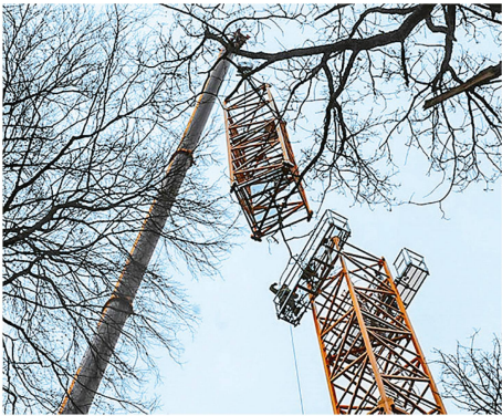
Abb 1 Installation des Baukrans für das Langzeitexperiment in Hölstein (BL). Foto: Universität Basel
