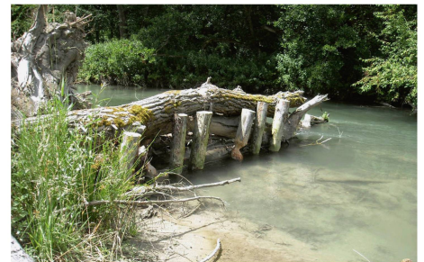
Abb 2 Revitalisierungsmassnahmen an der Alten Aare. Foto: Amt für Wald des Kantons Bern
