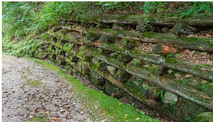
Abb 3 Hätten gepflanzte Bäume die Stabilisierung des Hanges übernehmen können, bevor der Holzkasten endgültig verrottet?
