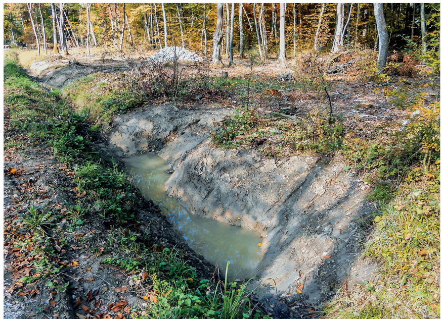
Fig. 4 Travaux de terrassement, surcreuses et élargissements de fossés.
