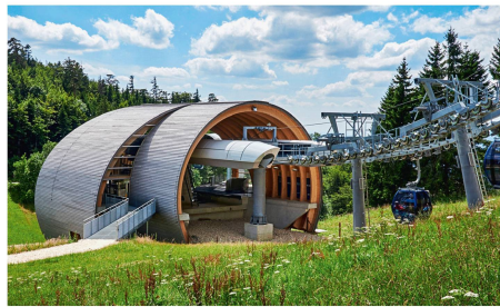
Abb 1 Station der Weissensteinbahn, Oberdorf SO. Foto: Corinne Cuendet, Clarens/LIGNUM
