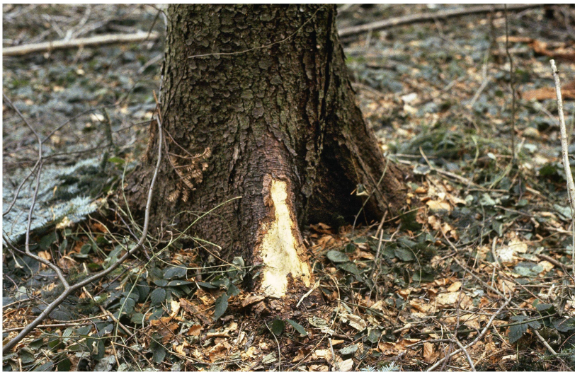
Abb 3 Durch Rückarbeiten beschädigter Wurzelanlauf. Foto: WSL
