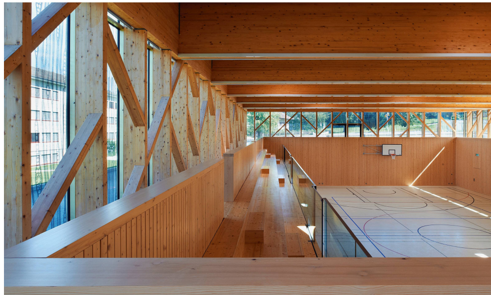
Fig. 2 Salle de sport à Attalens (FR) réalisée en bois suisse. Photo: Corinne Cuendet/Lignum
