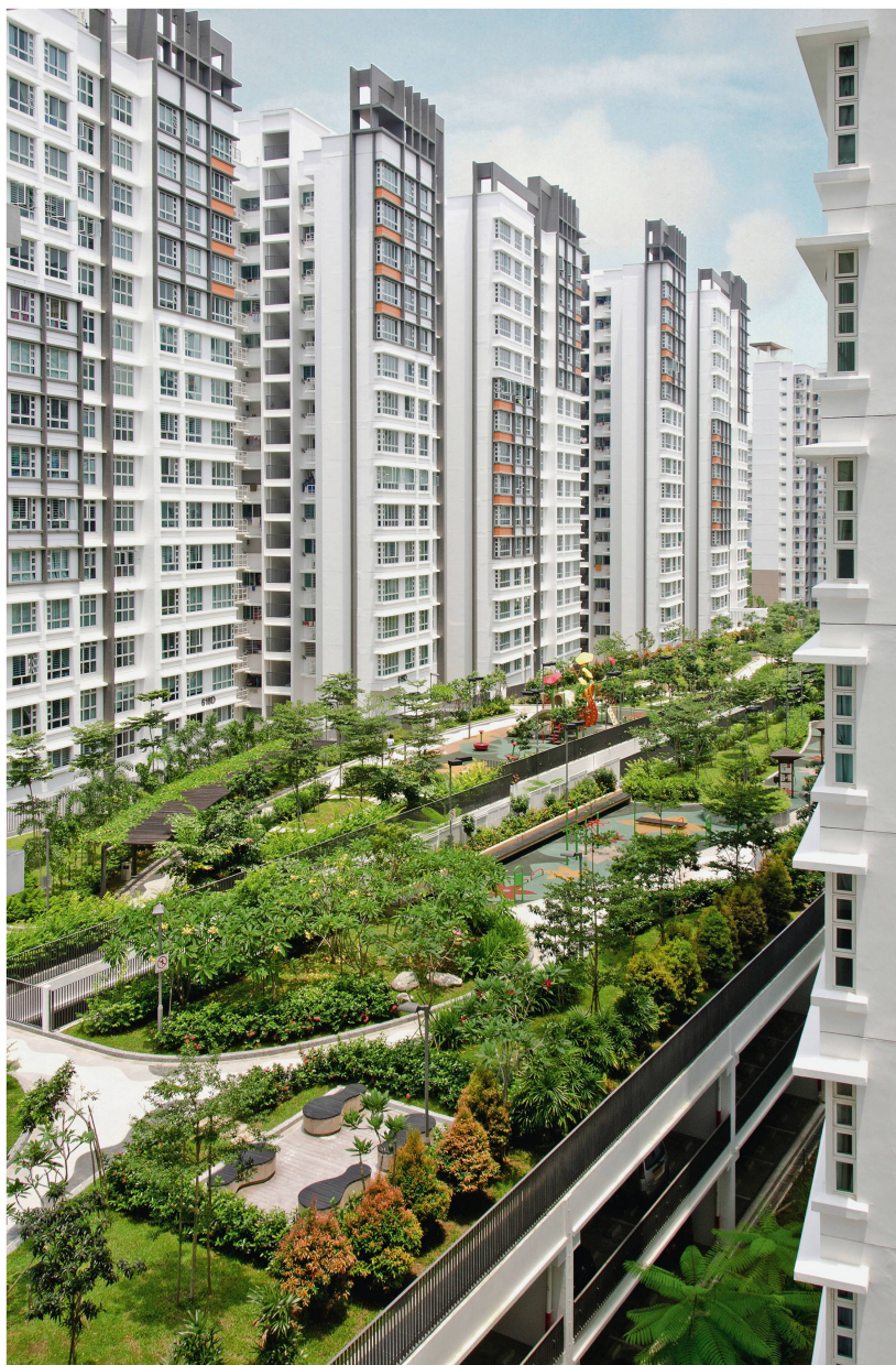
Abb 1 Parkanlage auf einem Hausdach in Singapur. Foto: NParks, 2013
