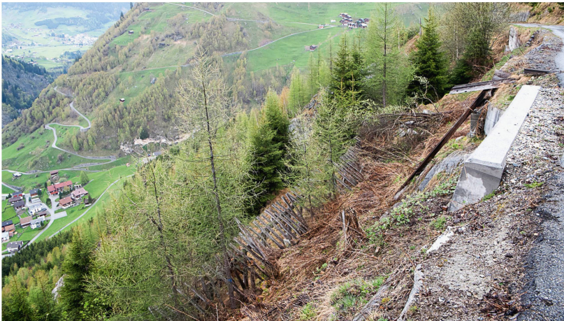
Abb 2 Die geräumte, verbaute und bepflanzte Fläche Curaglia, Stavel, am 7. Mai 2014: 24 Jahre nach dem Sturm ist die Schutzwirkung nahezu wiederhergestellt. Foto: Raphael Schwitter
