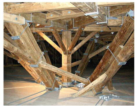
Dachstock der Klosterkirche von Einsiedeln.
