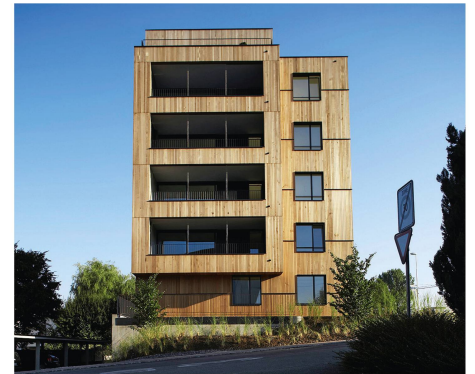
Abb 1 Das erste sechsgeschossige Haus in Holzbauweise der Schweiz wurde im Jahr 2006 in Steinhausen (ZG) erbaut. Mit den neuen Brandschutzvorschriften sind künftig deutlich höhere Holzgebäude möglich. Foto: Renggli, Sursee/Lignum
