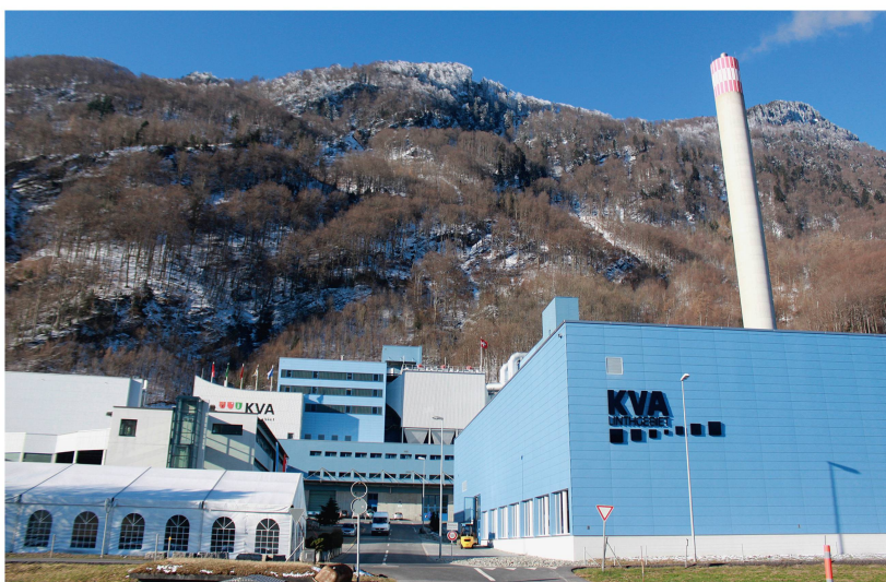
Abb 1 Die Kehrichtverbrennungsanlage Niederurnen liegt am Fuss eines Berghanges.
