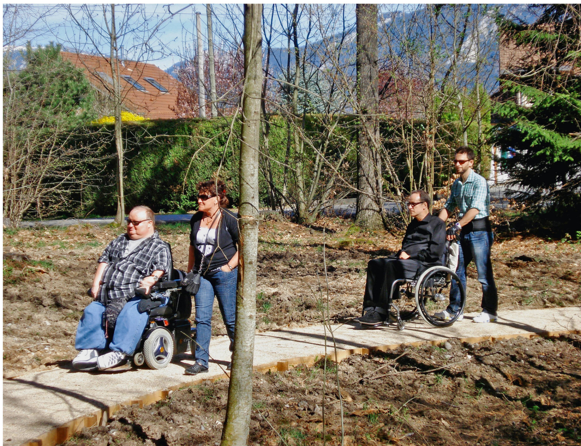
Fig. 1 Revêtement adapté du cheminement, étang de la Lèche, Saint-Martin-Bellevue (France).
