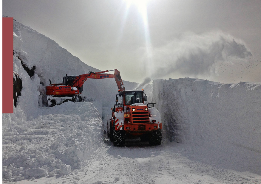
Abb 3 Die Schneeräumung bedingt insbesondere nach grossen Lawinenabgängen einen erheblichen Maschinen- und Zeitaufwand. Räumungsfahrzeug im Lawinenzug Nr. 34. Foto: O. Flepp, Pro Lucmagn
