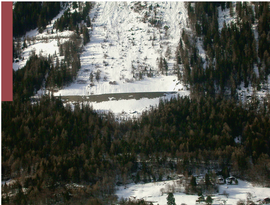
Fig. 4 Digue contre les avalanches. Les Faces (VS). Photo: R. Métral
