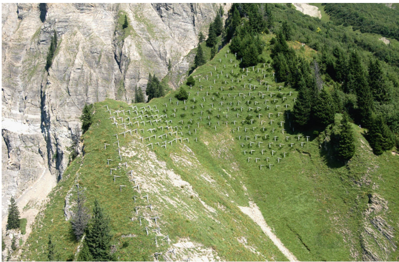
Abb 2 Hochlagenaufforstung mit Gleitschneeverbauung am Schwanderort (1730–1780 m ü. M.).
