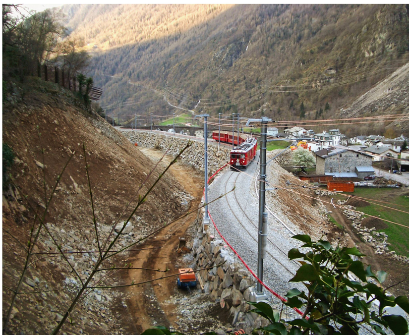
Abb 4 Schutzdamm nach dem Felssturzereignis in Brusio (GR) vom Dezember 2008. Zusammenarbeit von privaten und öffentlichen Akteuren beim Risikomanagement von Naturgefahren. Foto: Ralph Rechsteiner, RhB
