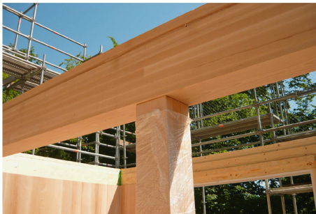
Construction en hêtre réalisée pour le nouveau bâtiment d'exploitation à Albisgütli, Zurich.
