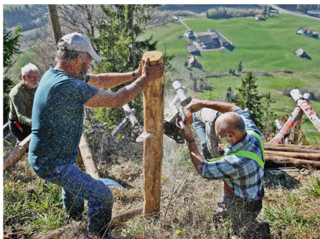
Die Privatwaldbesitzer zeigen vollen Einsatz beim Bau von Dreibeinböcken für den Schutz der Talschaft. Foto: Alfons Teuffer
