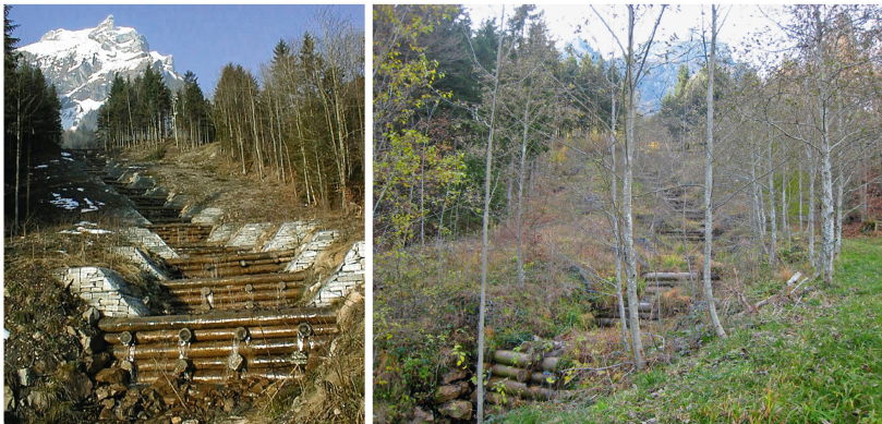
Abb 1 Sperrentreppe Steingraben bei Hergiswil (NW) im November 2001 (links) und im November 2010 (rechts).
