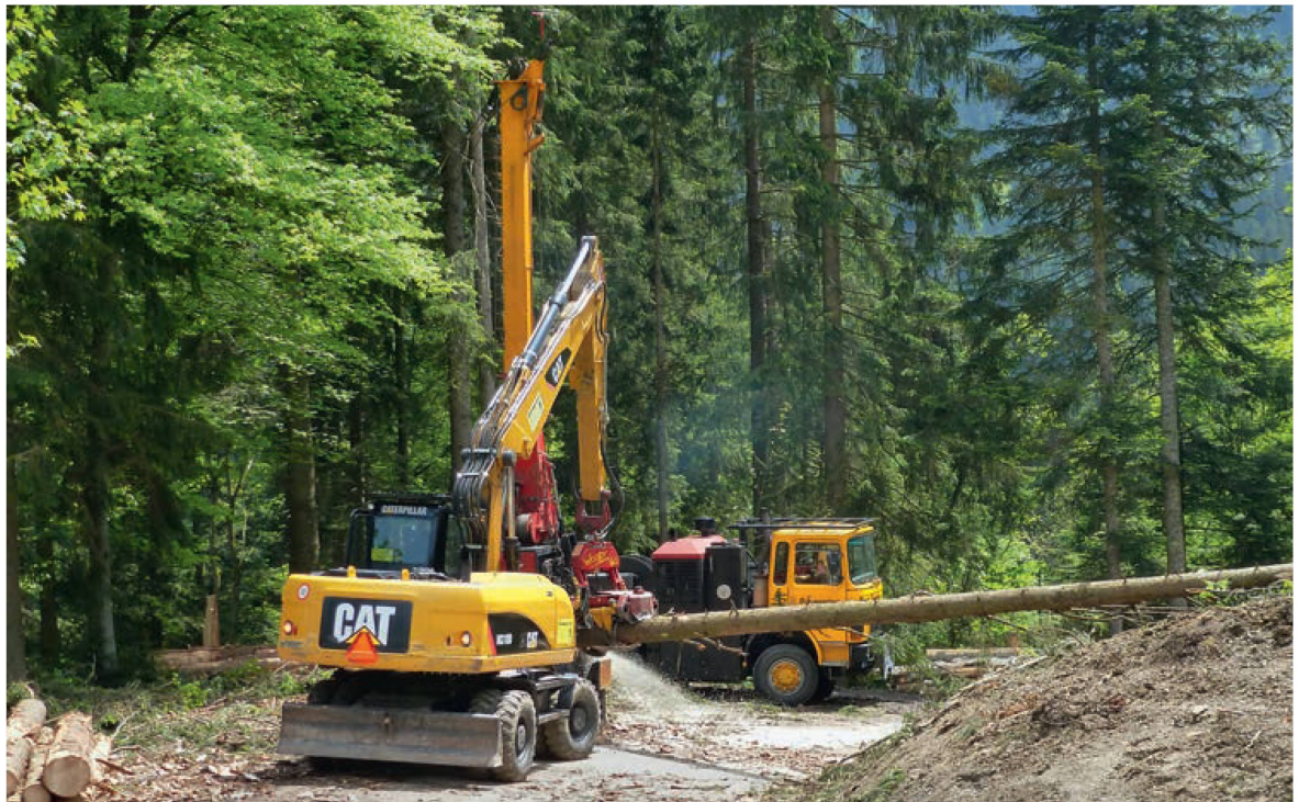
Abb 1 Installations- und Aufarbeitungsplatz eines Seilschlags.
