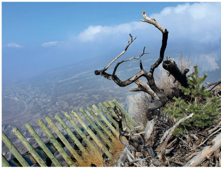
Abb 2 Dans 30 à 50 ans, les arbres garantiront la protection contre les chutes de pierres et les avalanches, mais en attendant, ce sont les ouvrages qui assurent celle-ci. Photo: Reinhard Lässig/WSL
